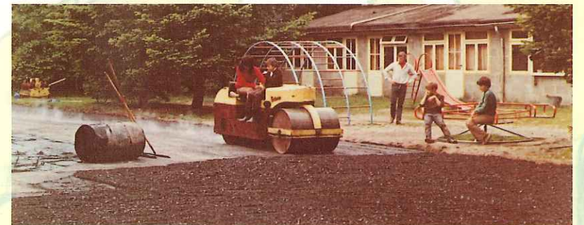
En laag asfalt vervangt het grasveld.
