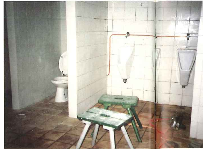
Verbouwing van de toiletten in de kantine.
