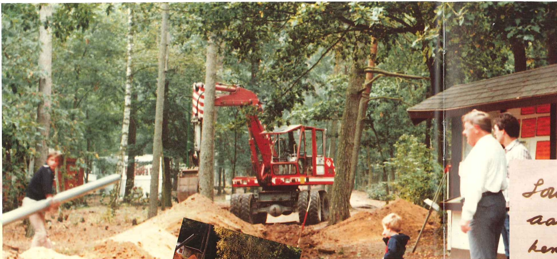
De aanleg van de riolering en de waterleiding
