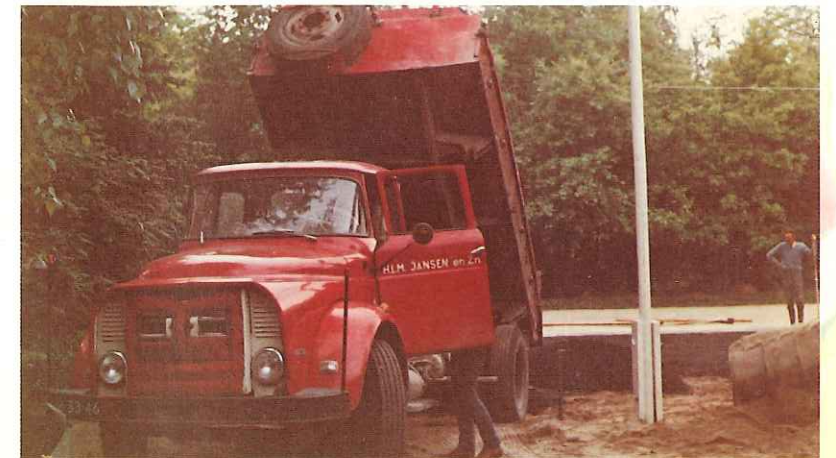
Het storten van het asfalt.
