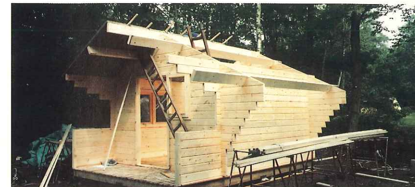
De bouw van de 2 trekkershutten.
